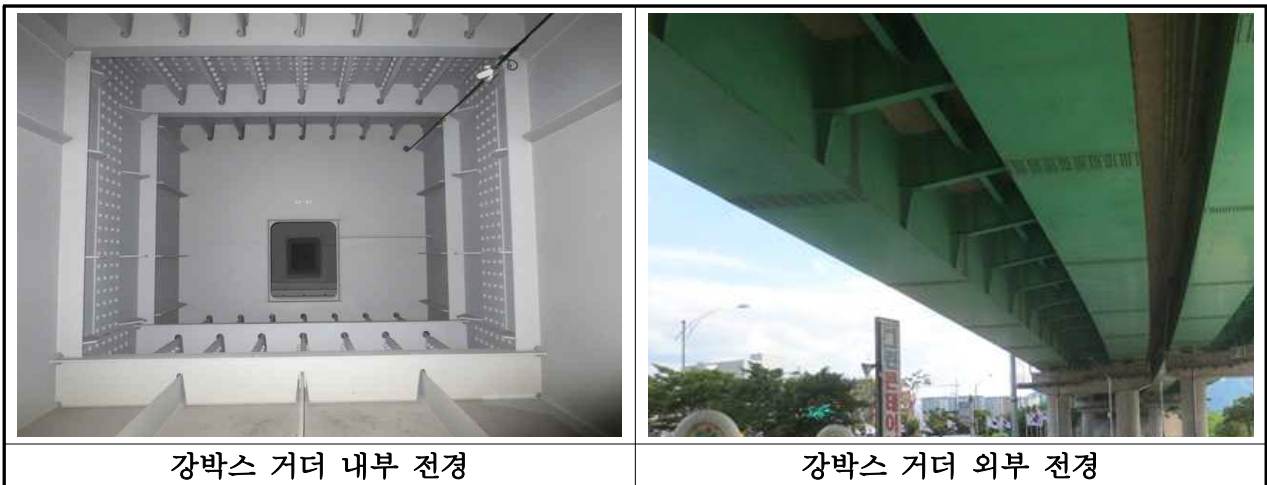
【사진 3.2.3】 강박스 거더 전경(대구)
