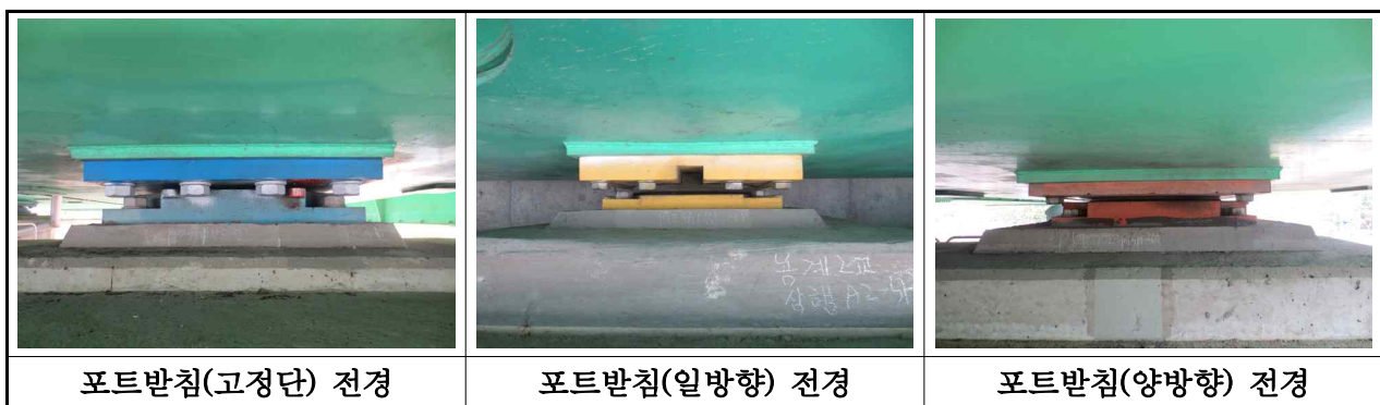
【사진 3.2.12】 교량받침 전경(대구)
