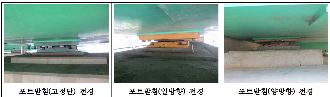
【사진 3.3.11】 교량받침 전경(부산)
