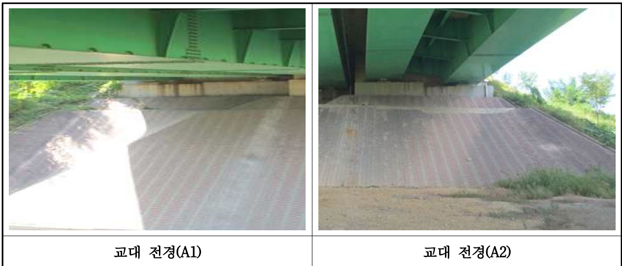
【사진 3.2.8】 교대 전경(대구)
