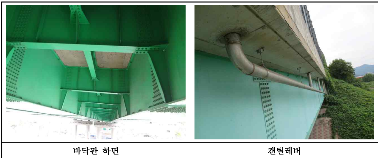
【사진 3.2.1】 바닥판 전경(대구)
