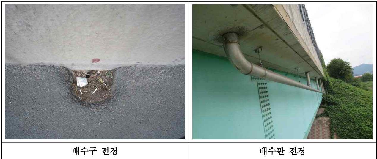
【사진 3.3.18】 배수구 및 배수관 전경(부산)
