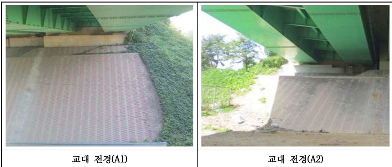
【사진 3.3.7】 교대 전경(부산)
